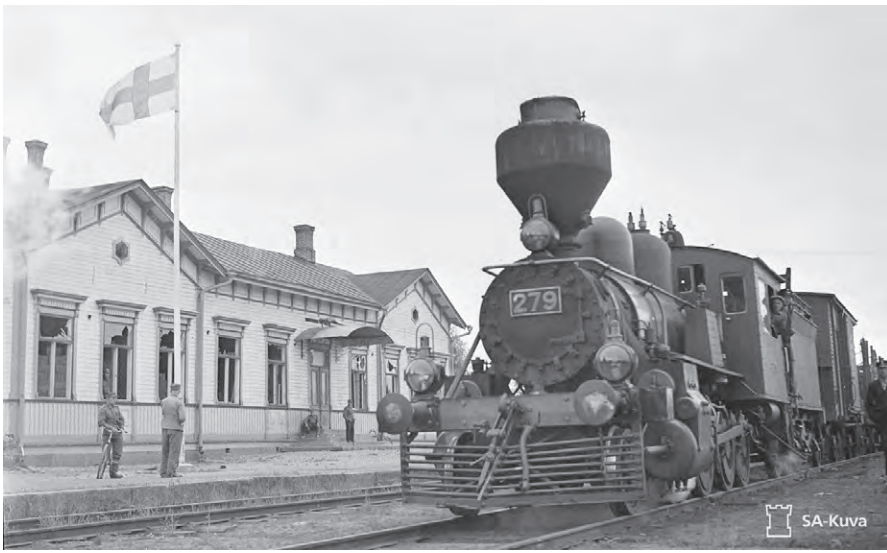
Hyökkäysvaiheen jälkeen alettiin rakentaa. Ensimmäinen juna saapui Värtsilän asemalle 16.7.1941. SA-Kuva.
