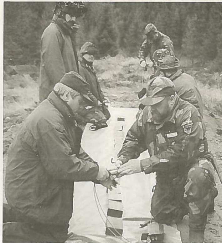
Tässä käännetään muoviräjähdetankoja sisältäviä laatikoita ja räjähtävää tulilankaa sisältävää pakettia, jolla on tarkoitus räjäyttää tie käyttökelvottomaksi.
