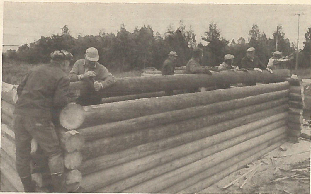
Yhteispelillä se sujuu ja vanhalla kokemuksella, se korsun rakentaminen rauhan aikana. Tosin mukana on nykyaikaista tekniikkaakin helpottamassa veteraanien työtä.
