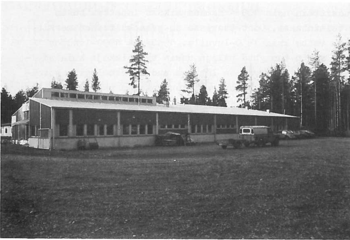
Eräs Käpykankaan Teollisuustalot Oy:n rakennuttamista halleista
