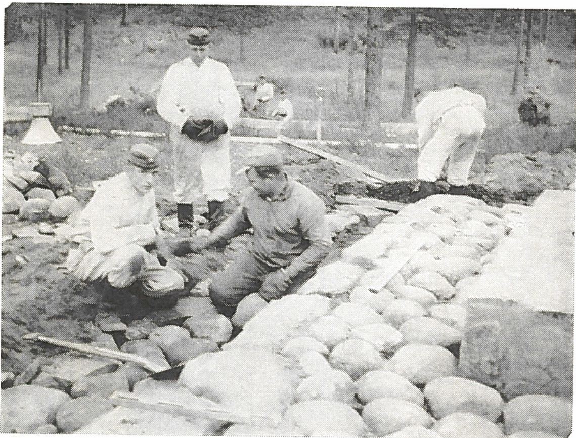
Muistomerkin jalustaa rakennetaan. Kuvassamme muurari Arvo Nissinen ja jääkäri Erkki Juntunen Nurmekselta asettamassa paikoilleen jalustakiviä, joita heille kantaa nurmekselainen jääkäri Arvo Pyykönen.
