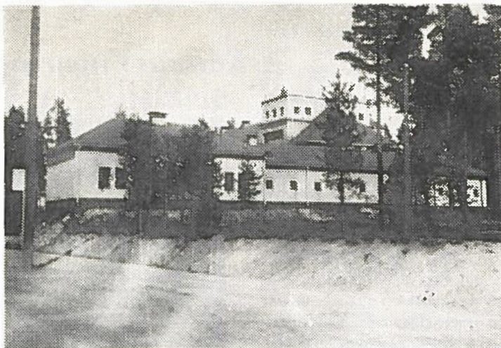
Esikunta- ja päävartiorakennus Huuhanmäellä.
